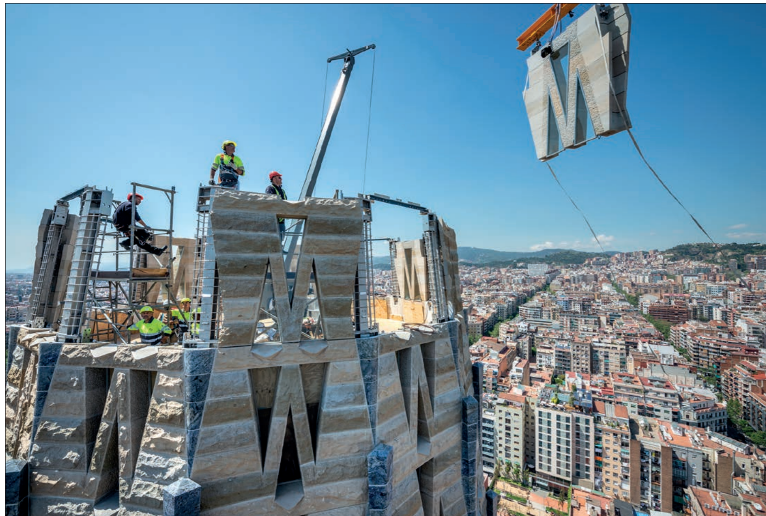
Lifting and placing a 25-tonne prestressed masonry panel for the Mary Tower high above the Barcelona skyline © Fundació Junta Constructora del Temple de la Sagrada Família
